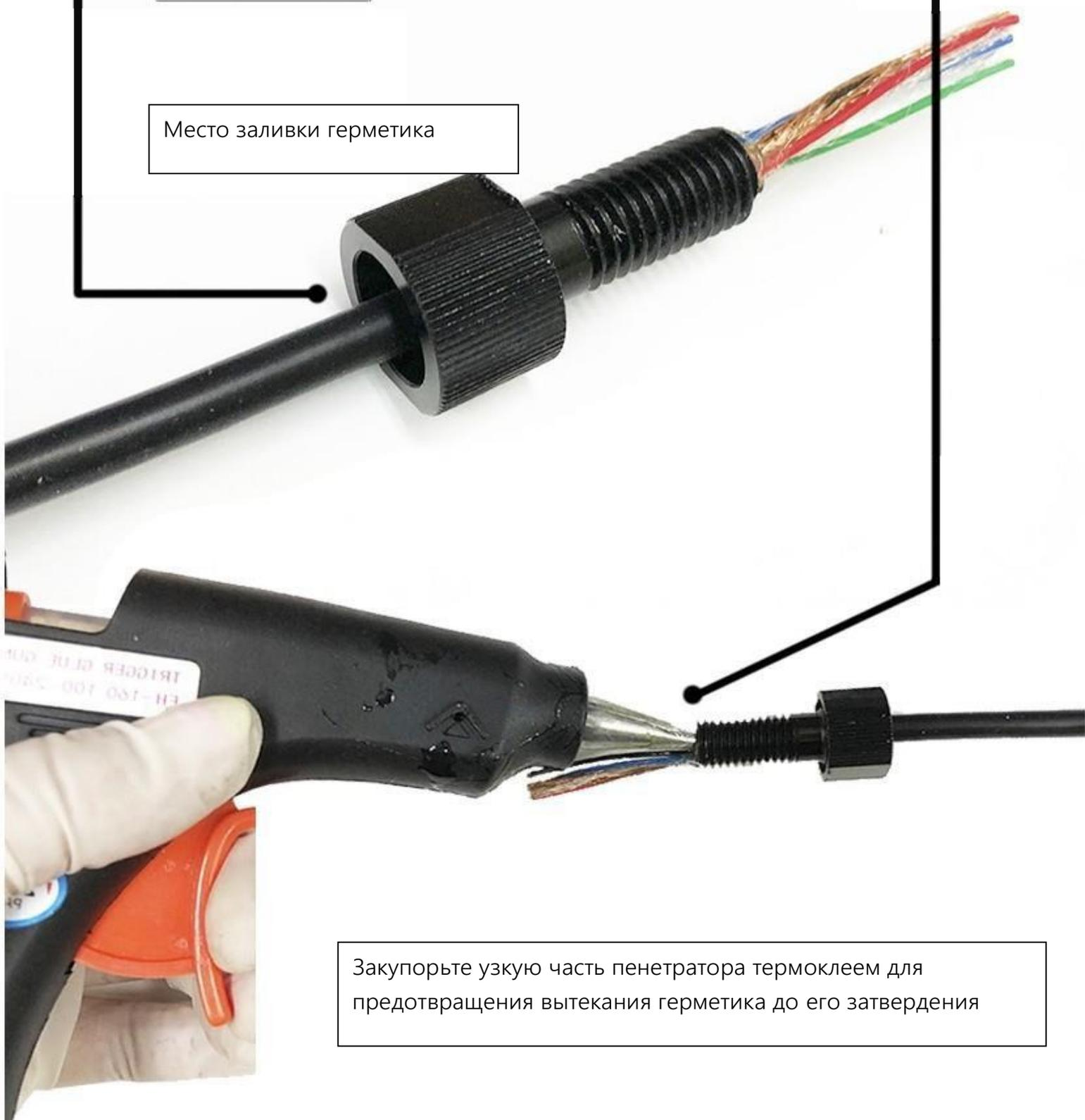
Закупорьте узкую часть пенетратора термостеклом для предотвращения вытекания герметика до его затвердения
